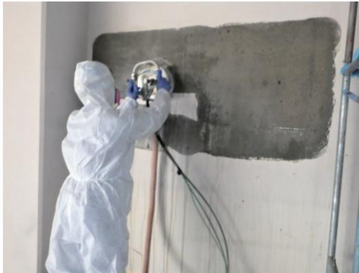
▲バキュームウォータージェット工法によるアスベスト除去作業の様子
