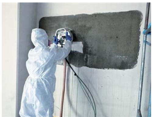
VAWM工法の施工風景
